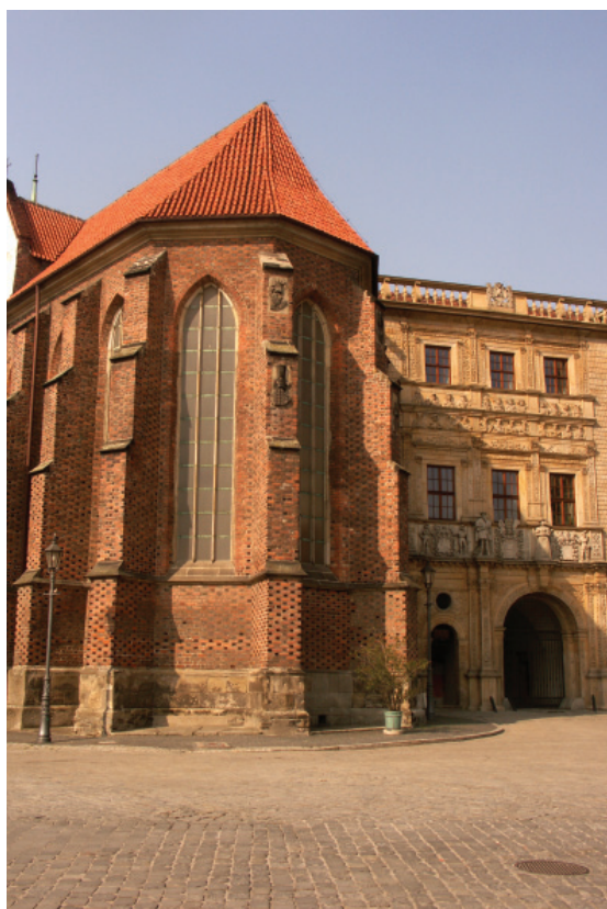
Fasada budynku bramnego
