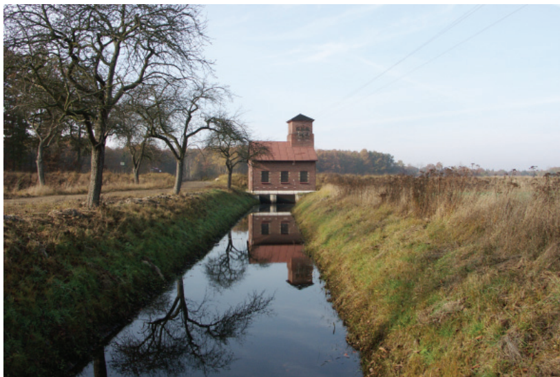
Stacja pomp w Błotach, z tyłu Las Odrzański
